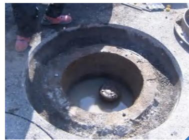
既設鉄蓋撤去
