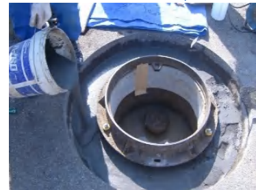
ボックス、鉄蓋の設置
