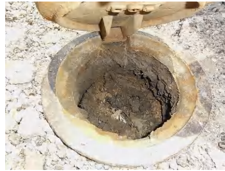
ボックス内への土砂の堆積
